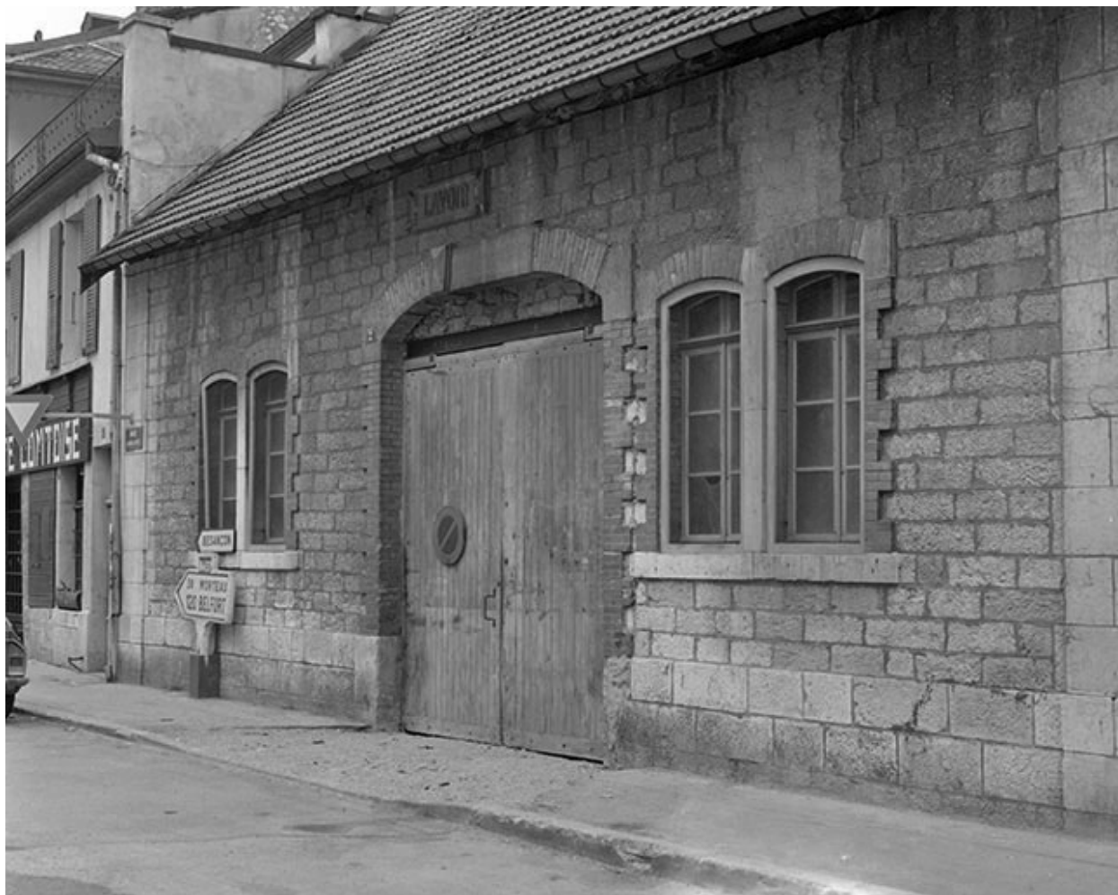
Façade sur rue, vue de trois quarts.
