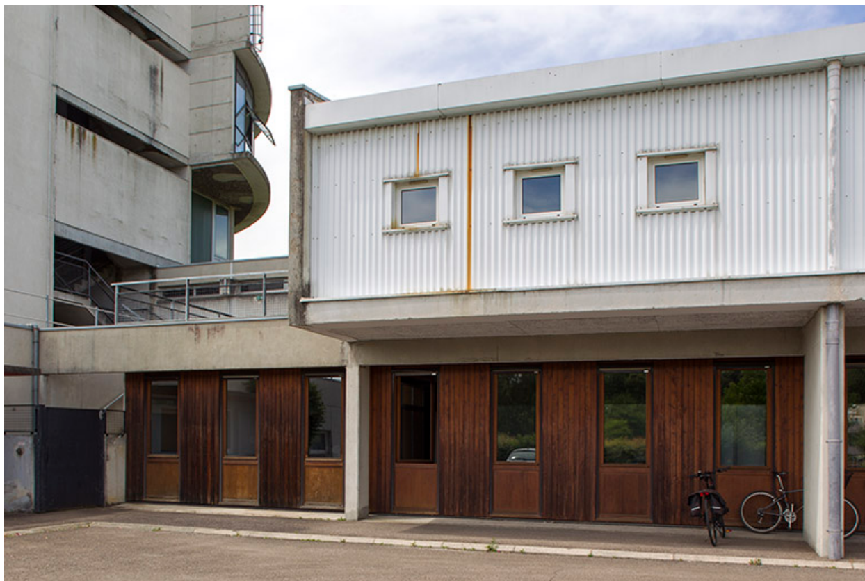
Entrée au rez-de-chaussée du bâtiment "agencement".
