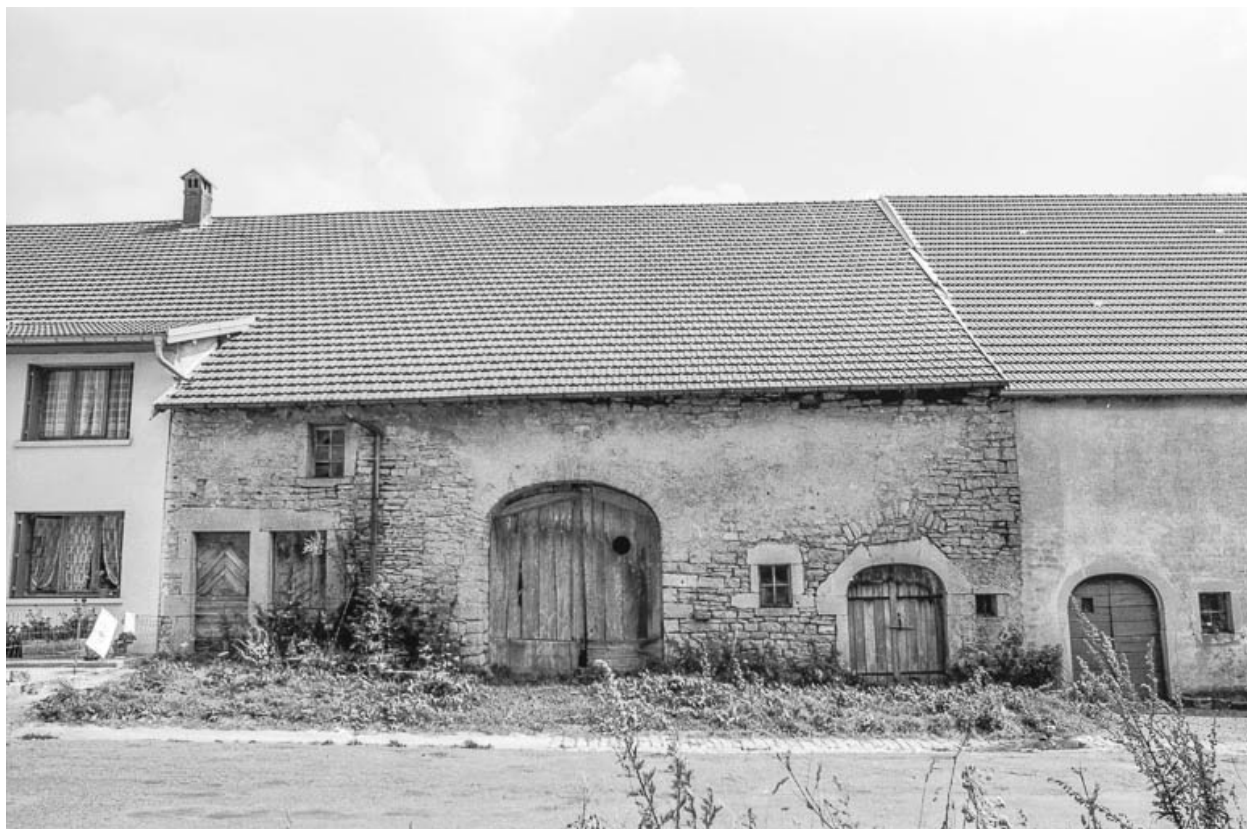
Ferme cadastrée 1951 E1 53 : façade antérieure.
