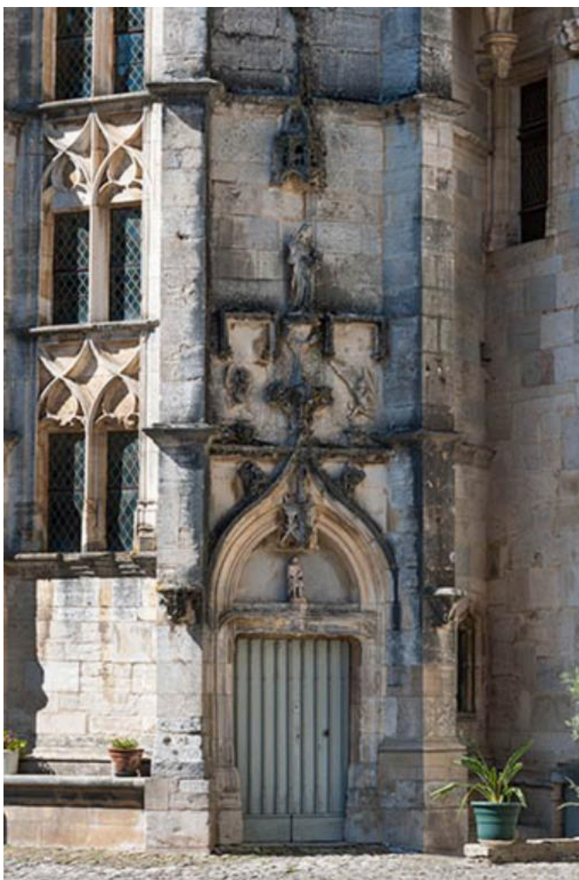
Porte de la tour d'escalier
