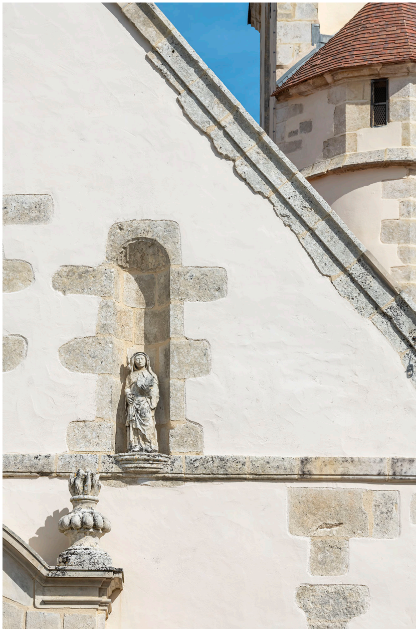
Détail de la façade principale : niche et pot à feu.
