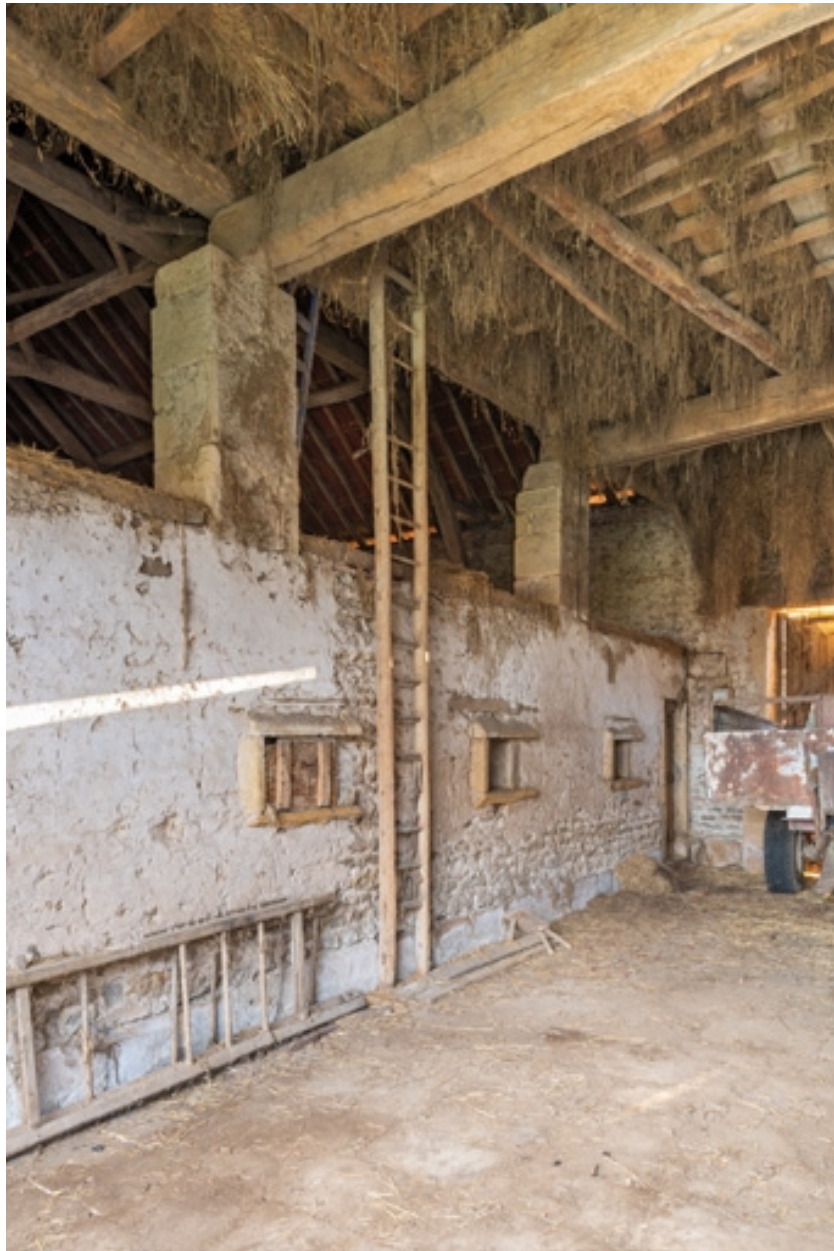
Remise pour le char à foin dans la grange
