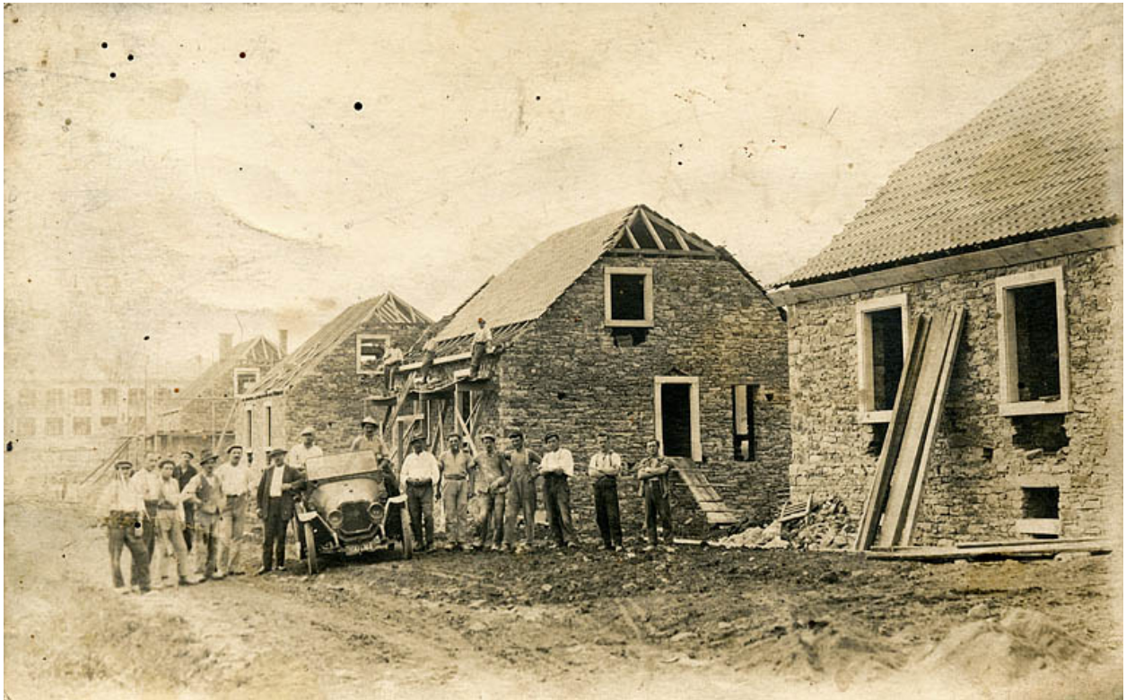
La cité ouvrière des Polognes en construction.
