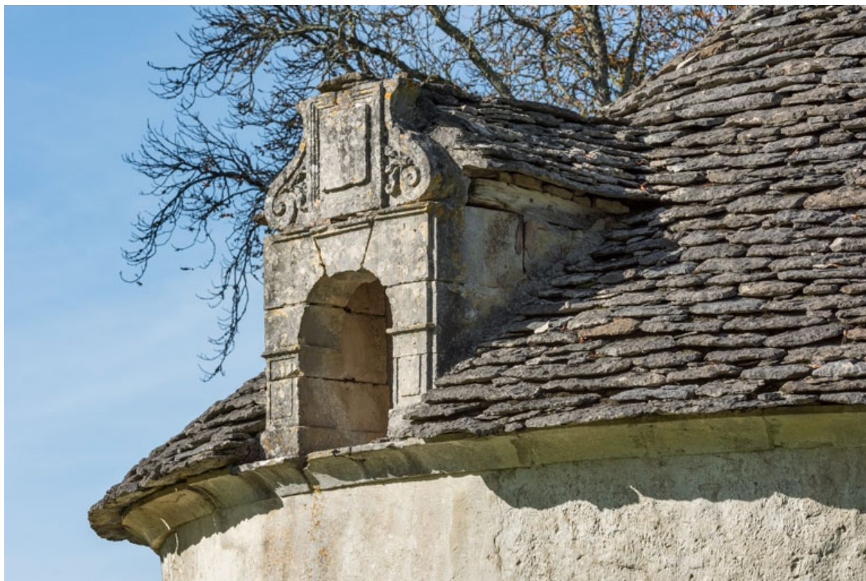
Détail de la lucarne sud.
