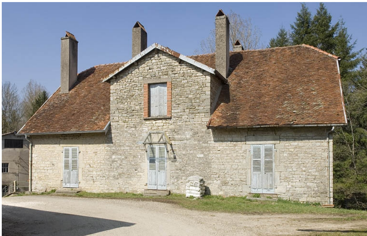
Façade sud du logement ouvrier.
