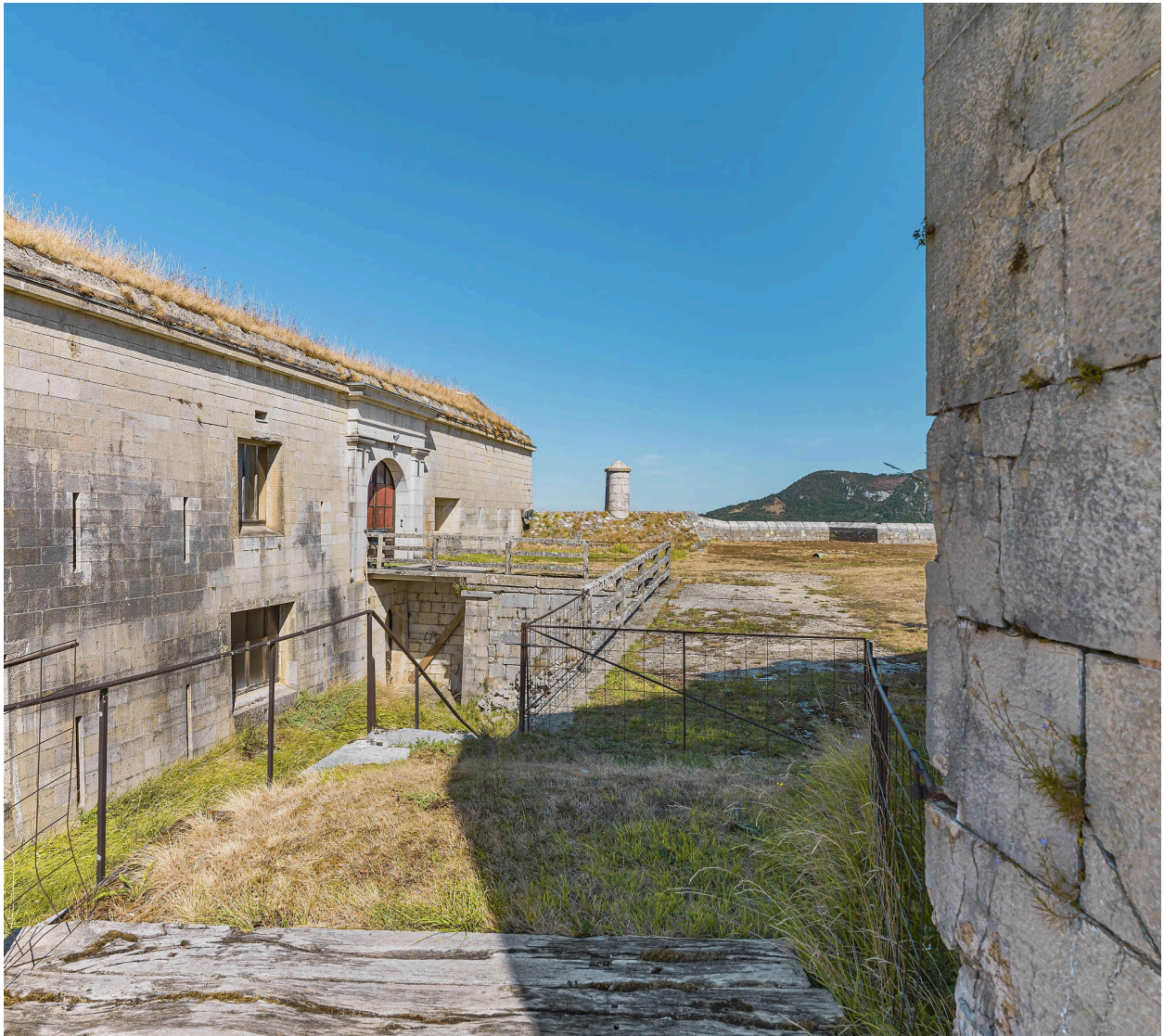
Vue sur le fossé encore existant, façade antérieure.
