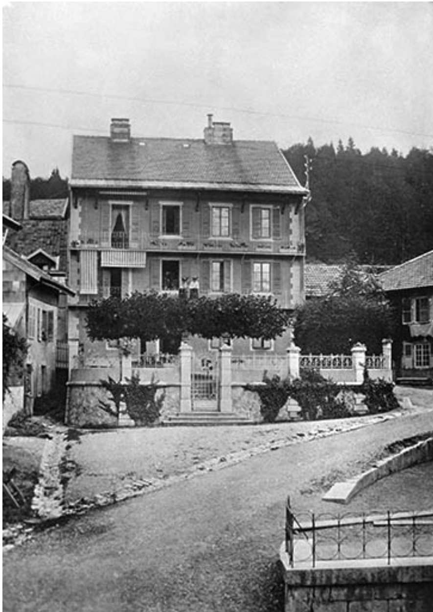
Façade antérieure du logement patronal.
