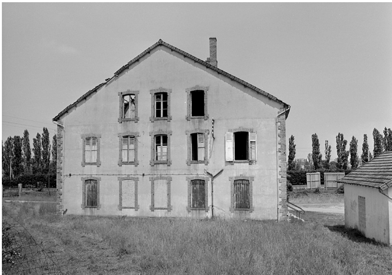
Façade postérieure du logement patronal et bureau.
