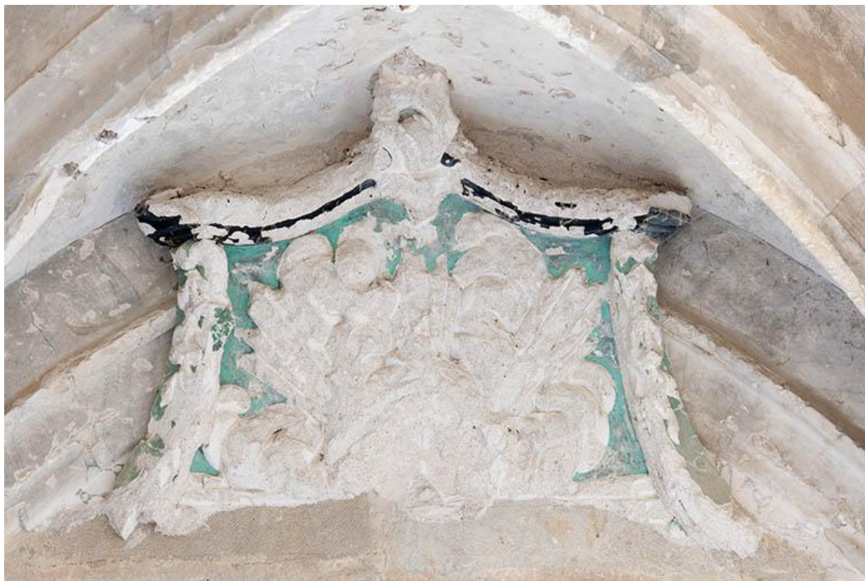
Décor de stuc situé sous la galerie
