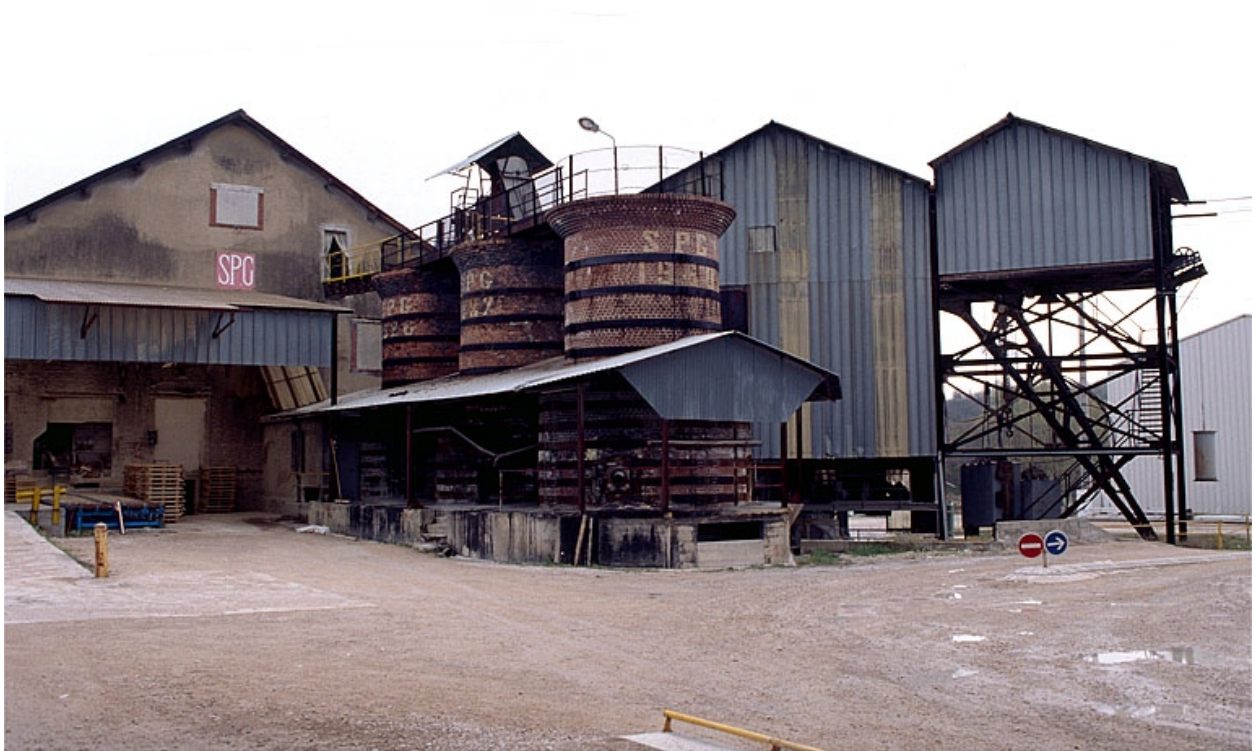
L'ancienne usine depuis le sud. De gauche à droite : bâtiment des fours, anciens fours à surcuit, broyeur et poste de chargement.
