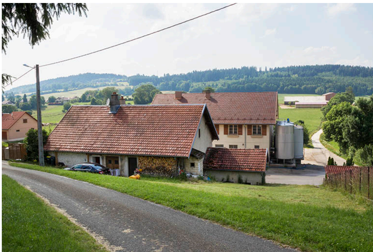
Ancienne fromagerie : façade postérieure (vue du nord-est).
