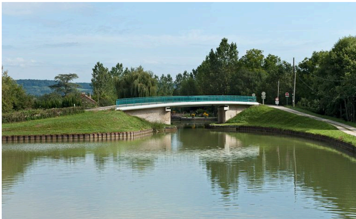
Vue du pont.
