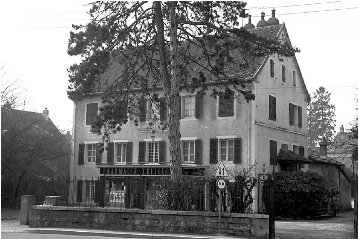
Façades antérieure et latérale droite.
