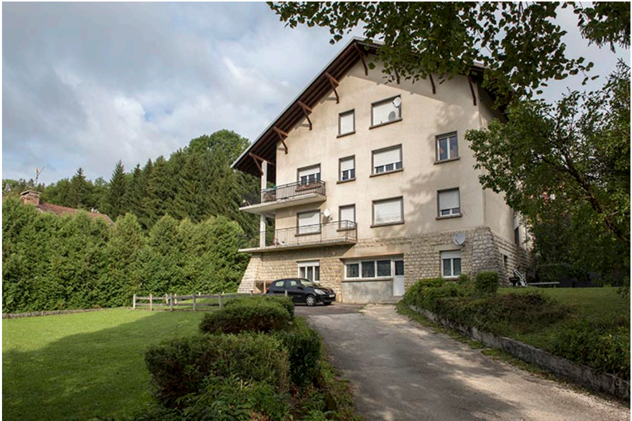
Maison : façade postérieure, de trois quarts droite.
