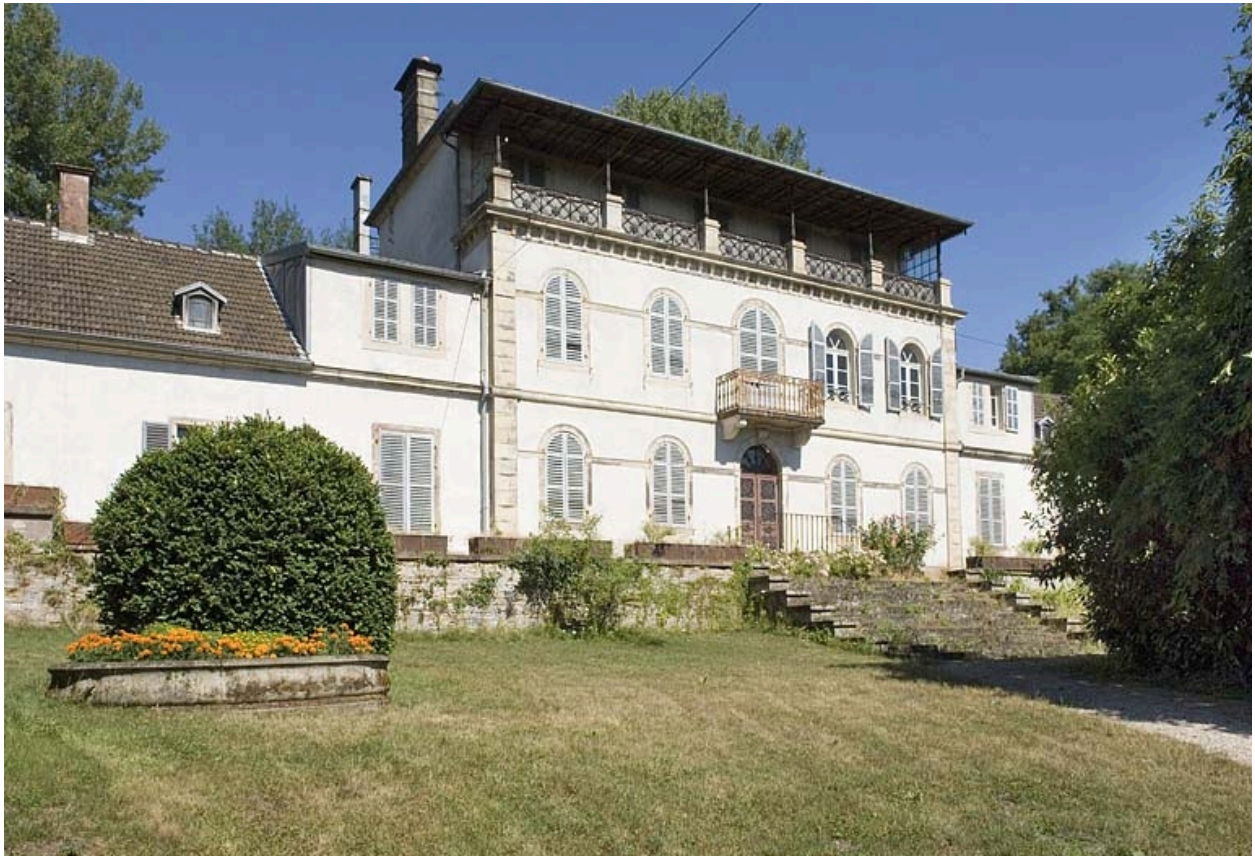
Logement patronal nord. Façade antérieure.
