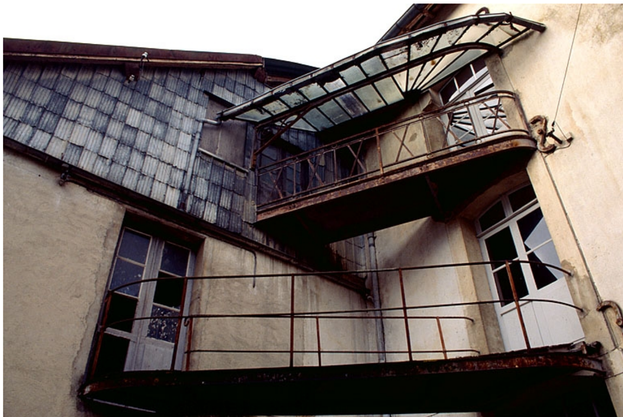
Ateliers de fabrication.Détail des passerelles.
