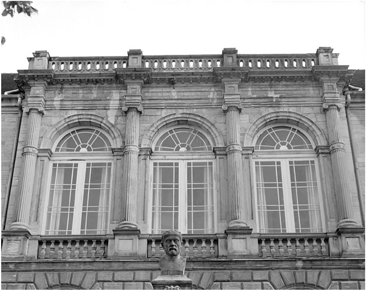
Façade nord. Détail : partie supérieure de l'avant-corps central.
