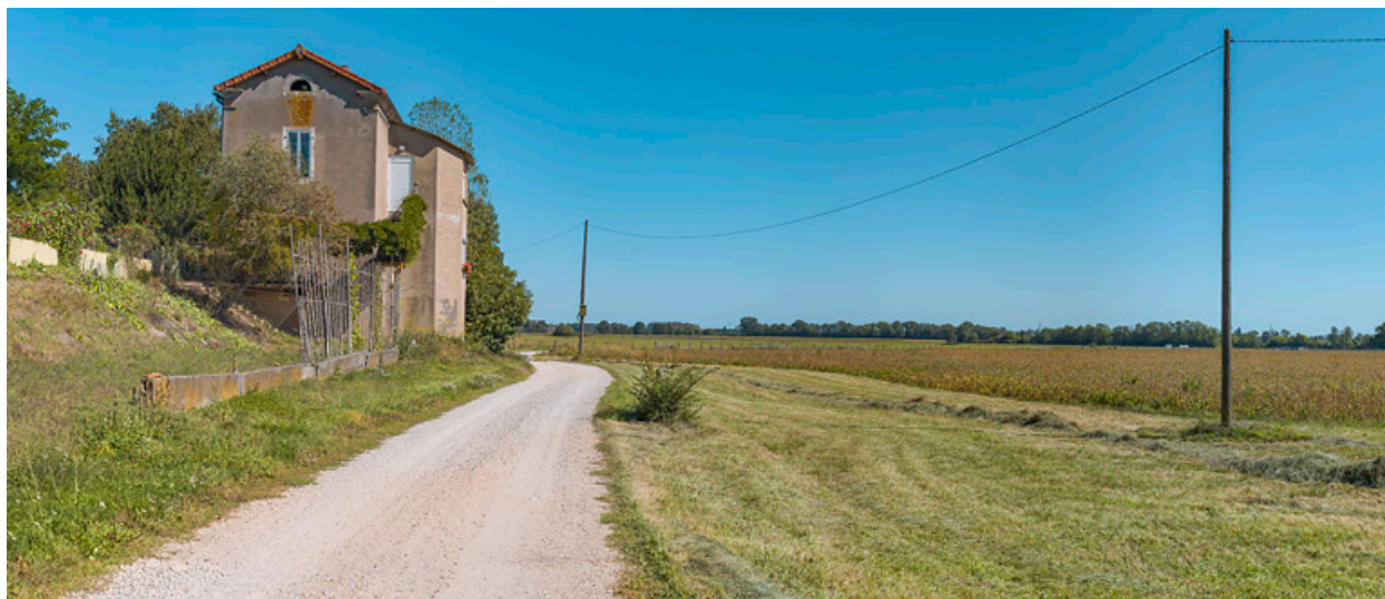
La maison éclusière, vue d'aval, dans son environnement paysager.
