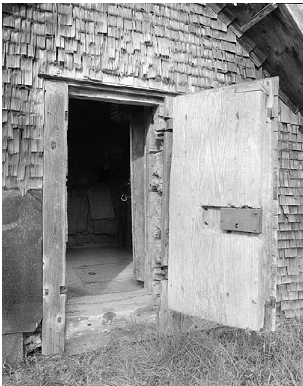
Les deux portes du grenier fort ouvertes.
