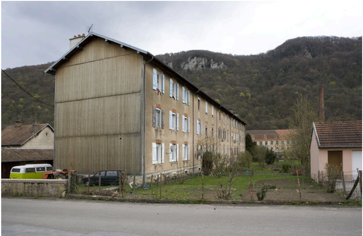
Logement d'ouvriers (10 à 16 rue des Ecoles). Façade sud-ouest.
