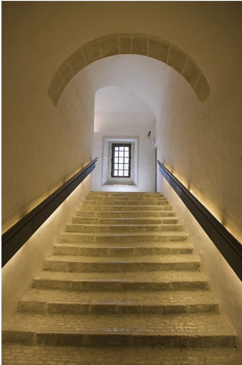
Escalier : troisième volée.
