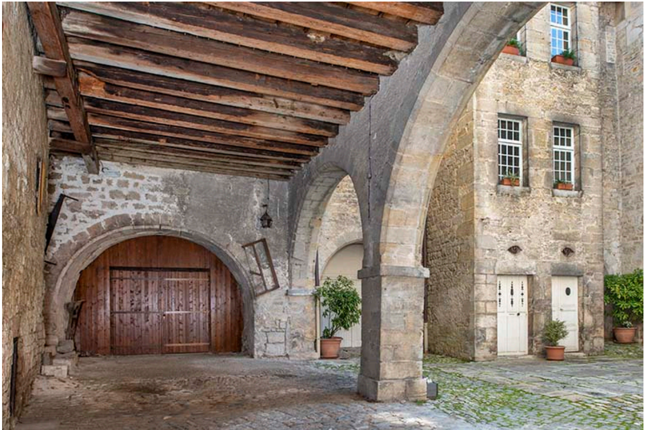
La cour depuis le passage couvert nord.
