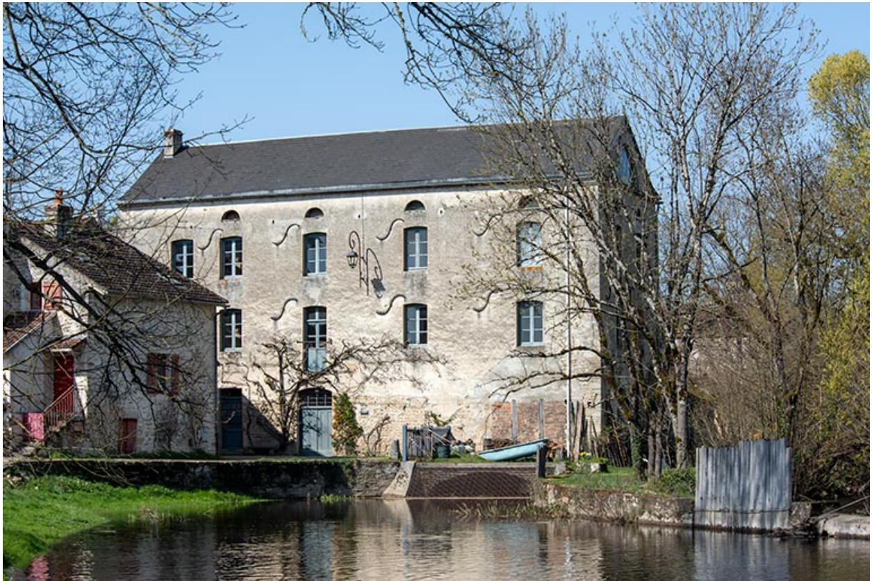
L'ensemble du moulin depuis la Cure.
