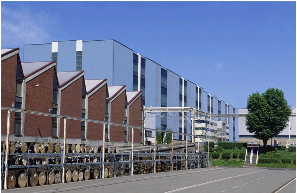
Vue d'ensemble d'un atelier Traction et de la halle 330.
