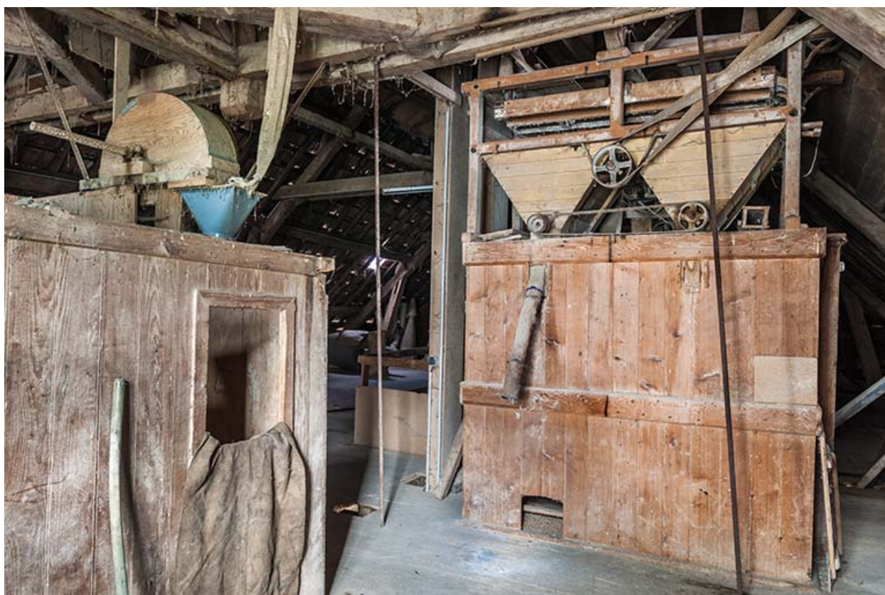
Etage de comble. Chambres à grains.
