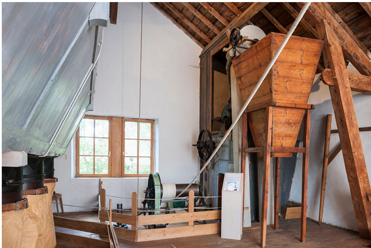
Troisième étage. Vue d'ensemble.
