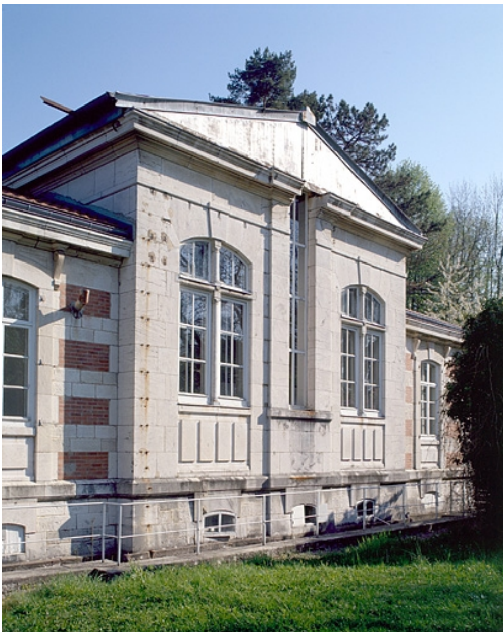
Façade sud, de trois quarts gauche.
