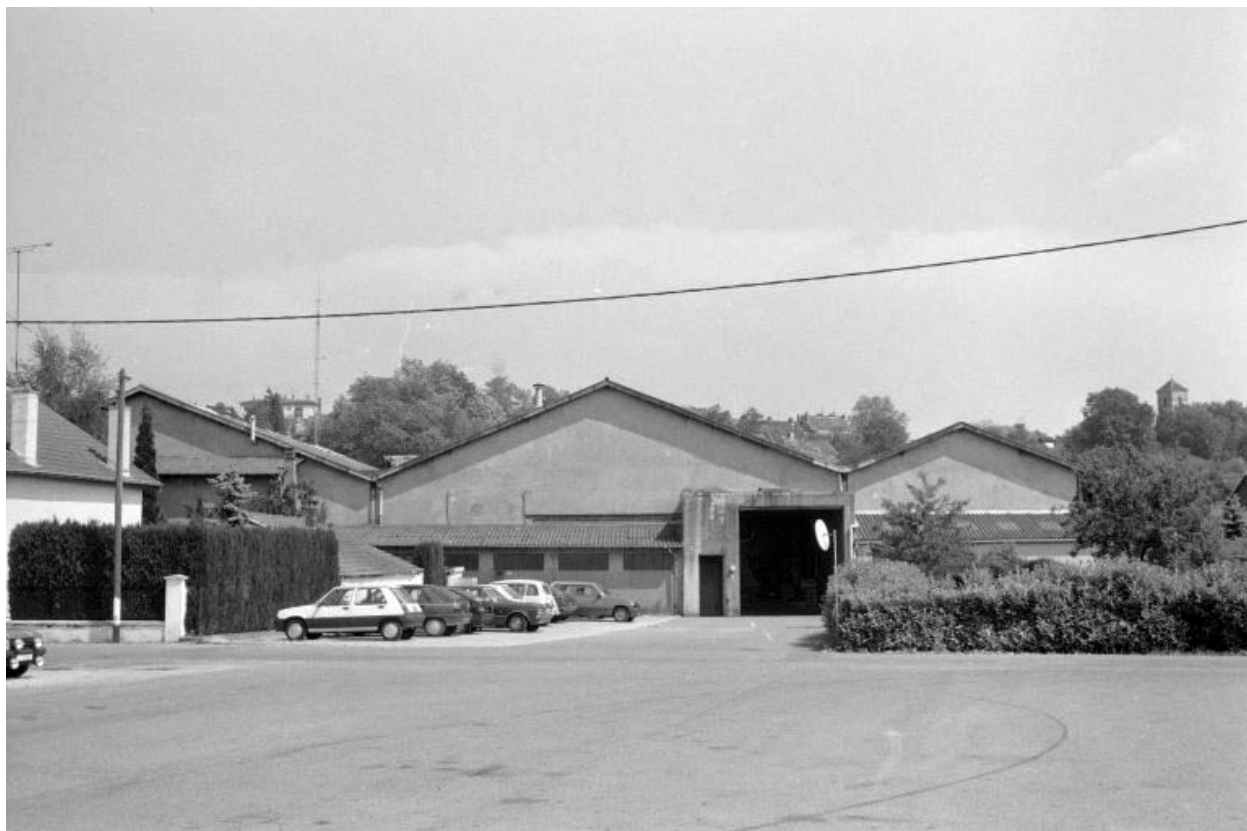
Façade postérieure vue de l'ouest.
