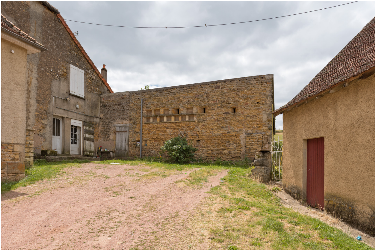
Mur d'une dépendance agricole (soue).
