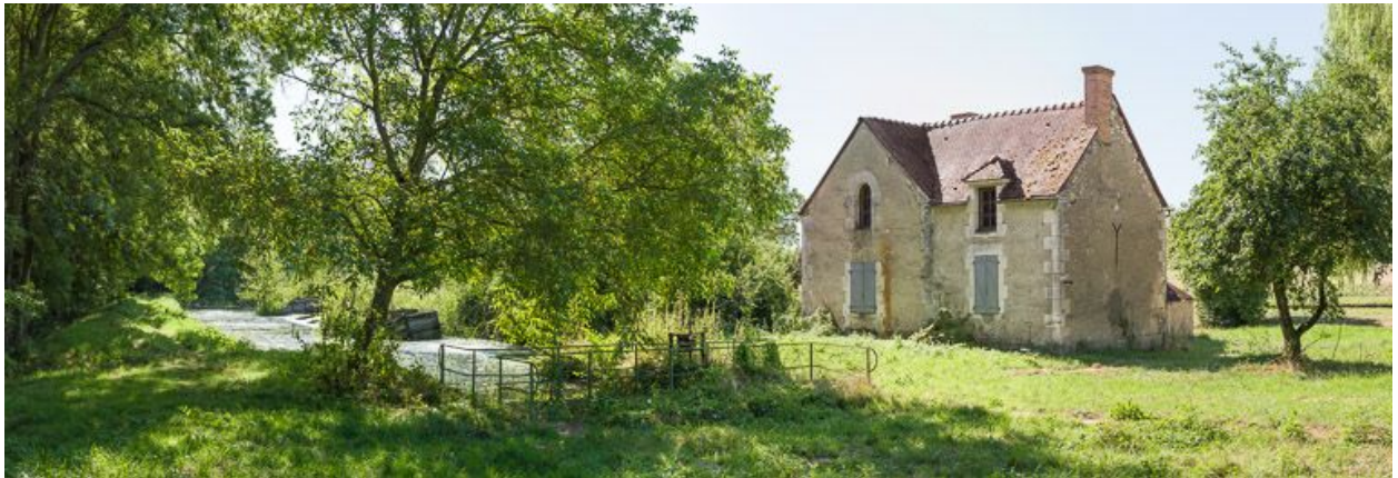
Vue d'ensemble du site d'écluse de Cravant, abandonné.
