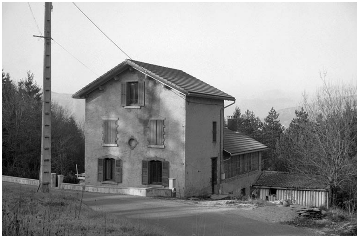
Façades antérieure et latérale droite.
