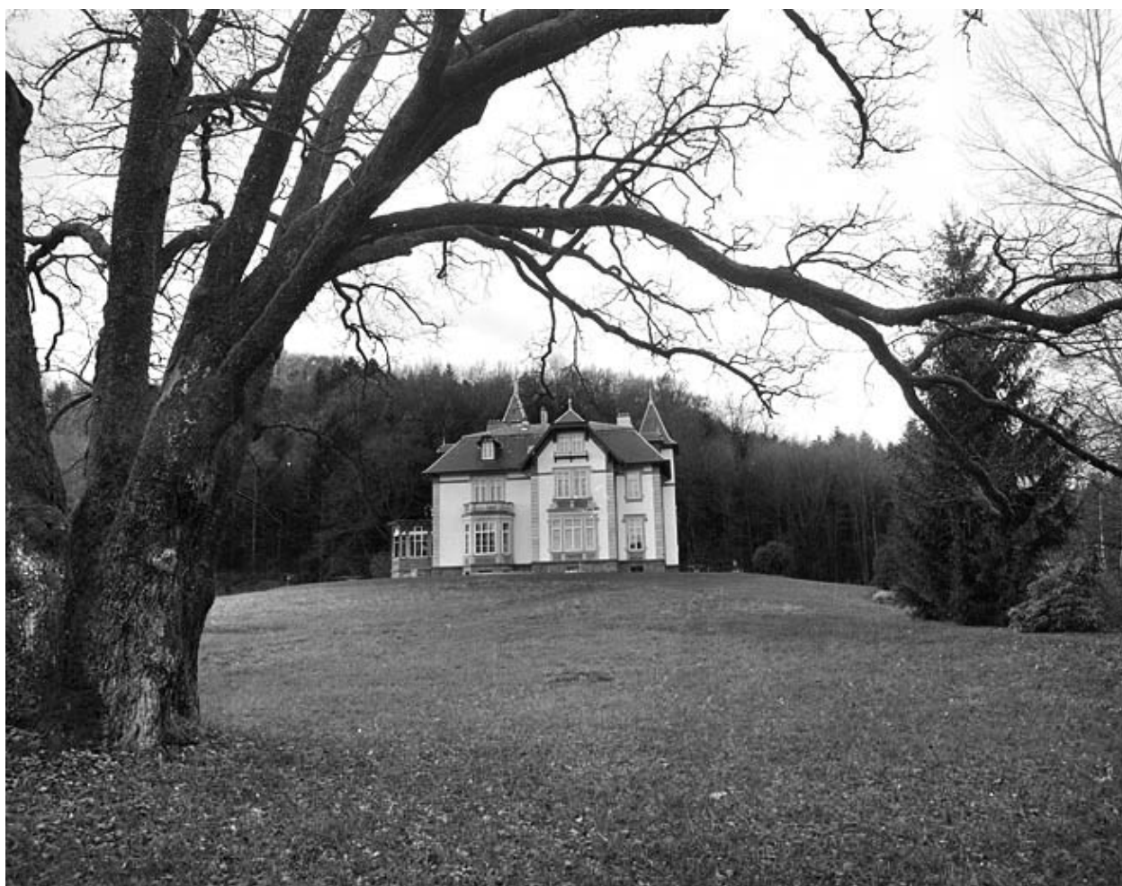
Vue d'ensemble du logement patronal.
