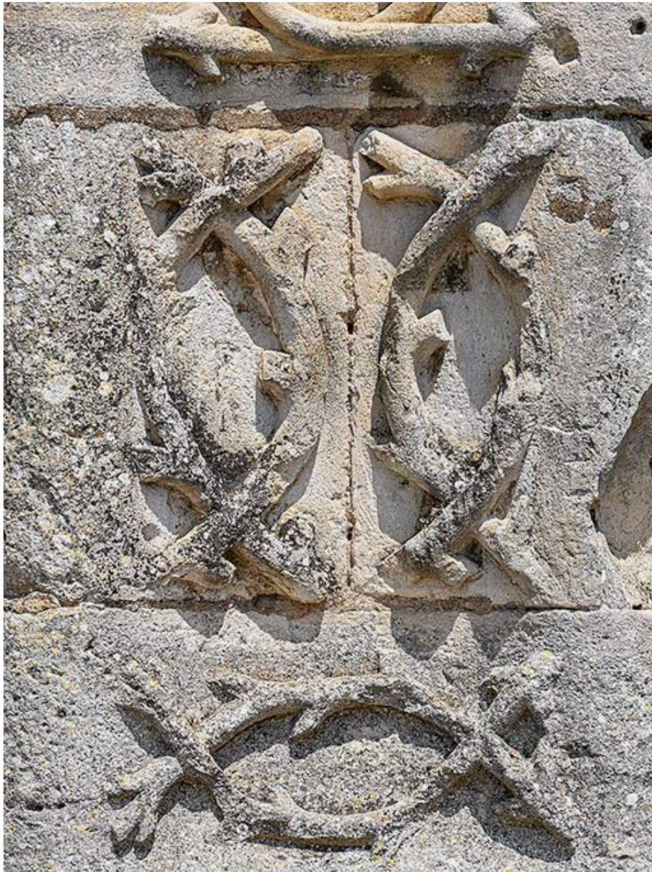
Détail des rinceaux végétaux.
