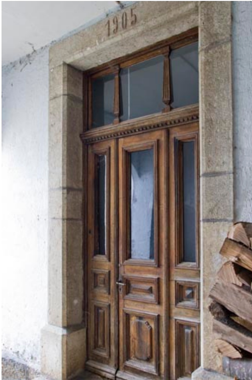
Entrée de l'usine (façade latérale droite).
