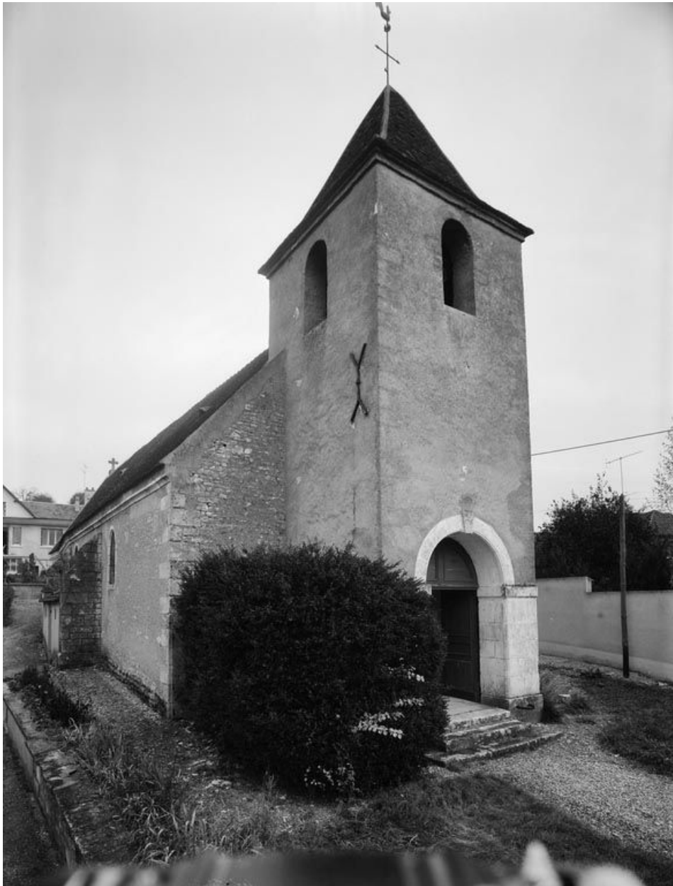
Façade antérieure et élévation gauche.
