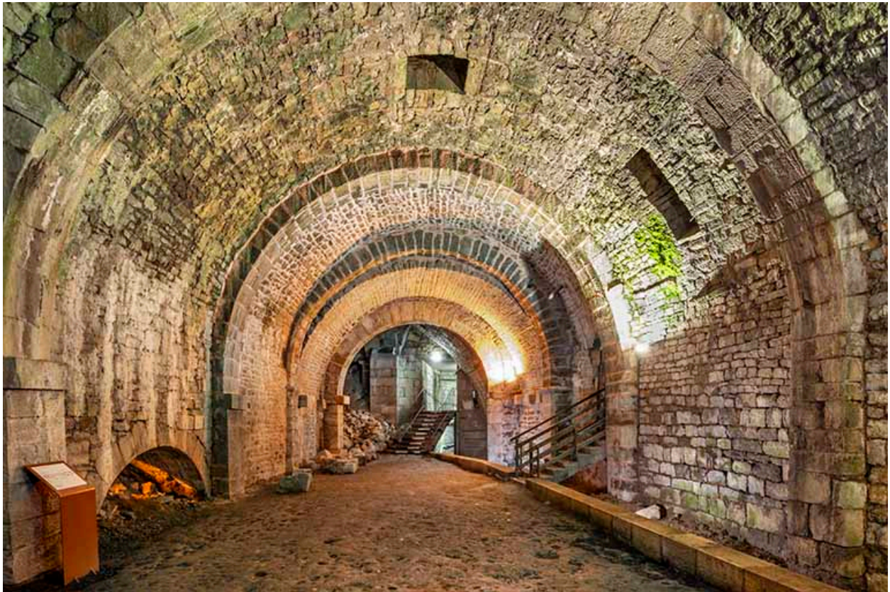
Puits d'Aval. Vue d'ensemble puis le nord.
