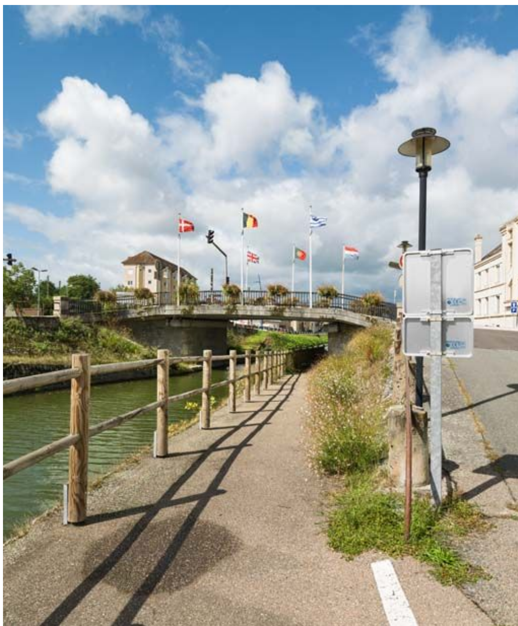
Vue d'ensemble du pont.
