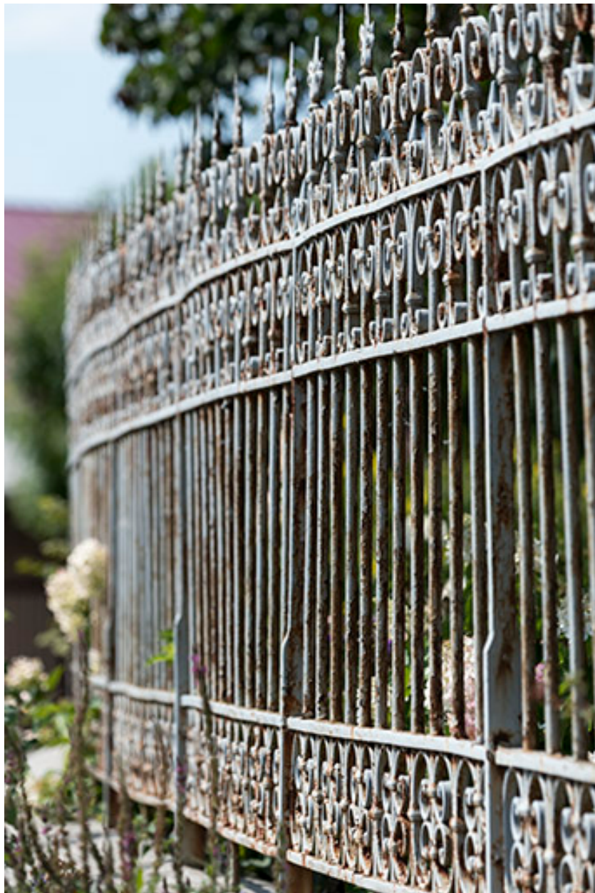
Clôture : grille, vue en enfilade.
