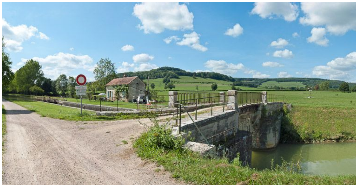
Vue d'ensemble du site d'écluse.
