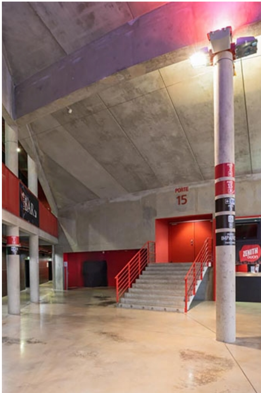
Vestibule : dessous des gradins et porte 15.
