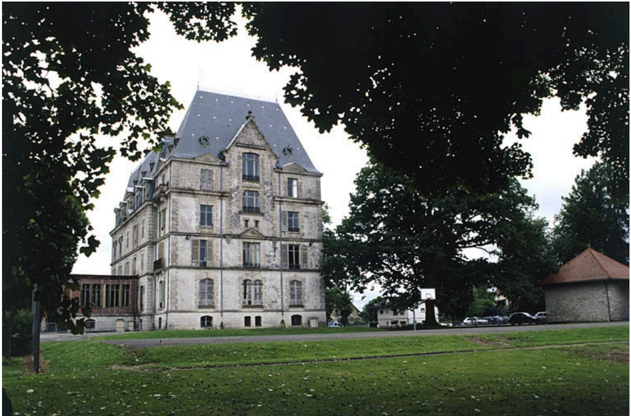
Façade ouest vue de trois quarts gauche.
