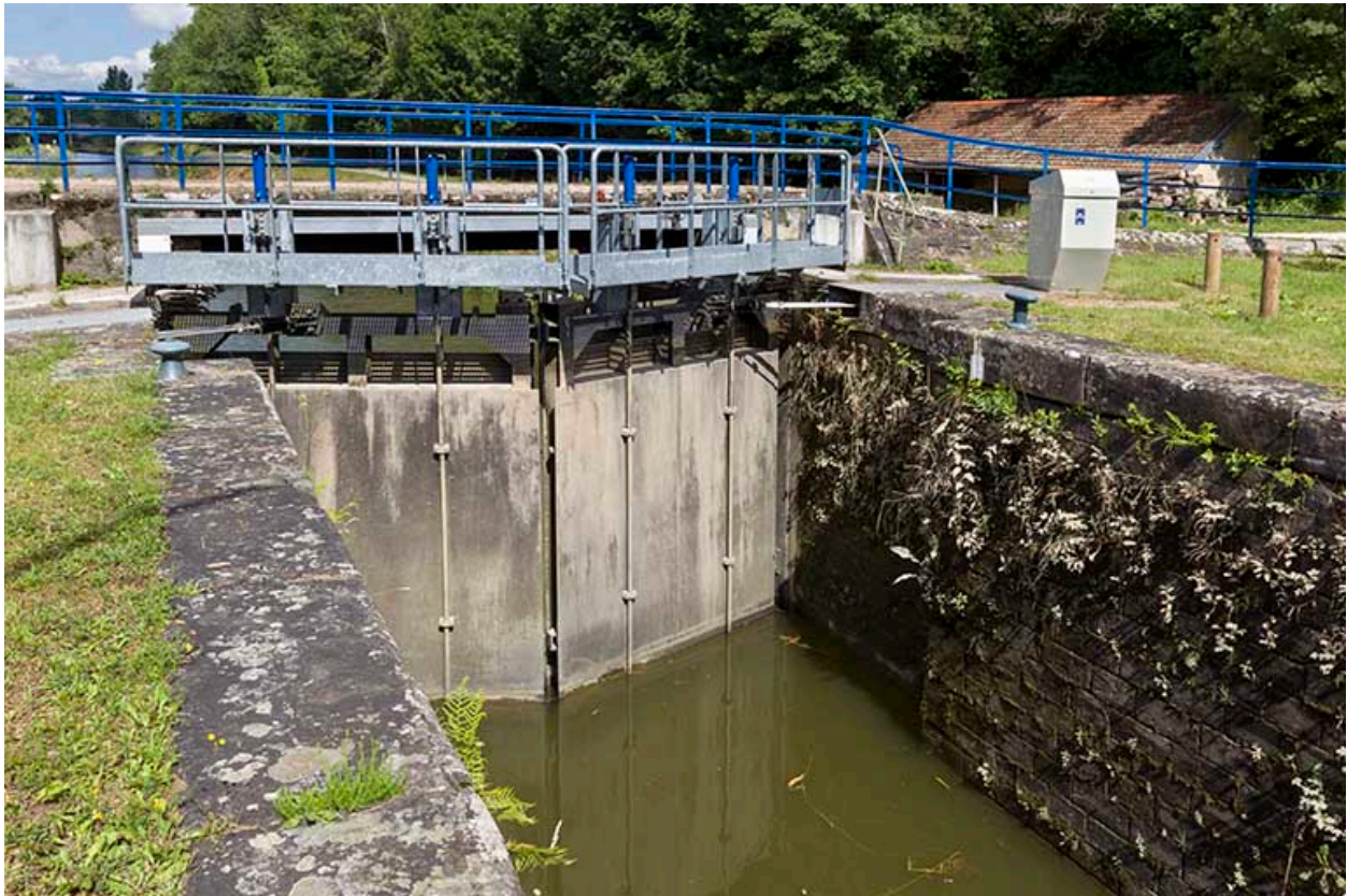
Les portes de l'écluse, busquées vers l'amont.
