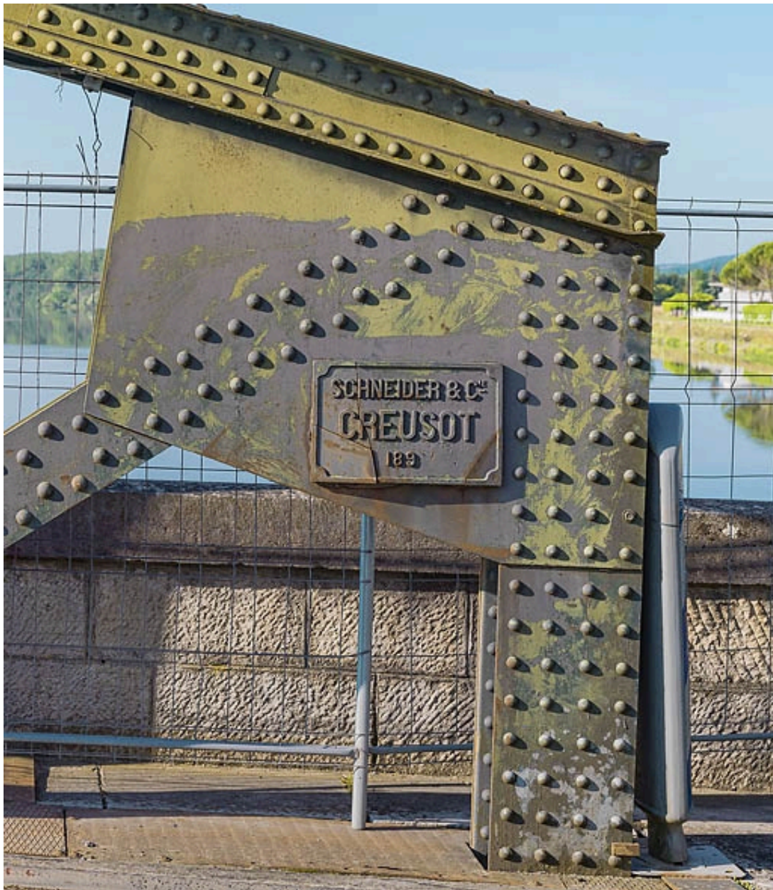
Détail de la structure métallique du pont et de la plaque "Schneider et Cie".
