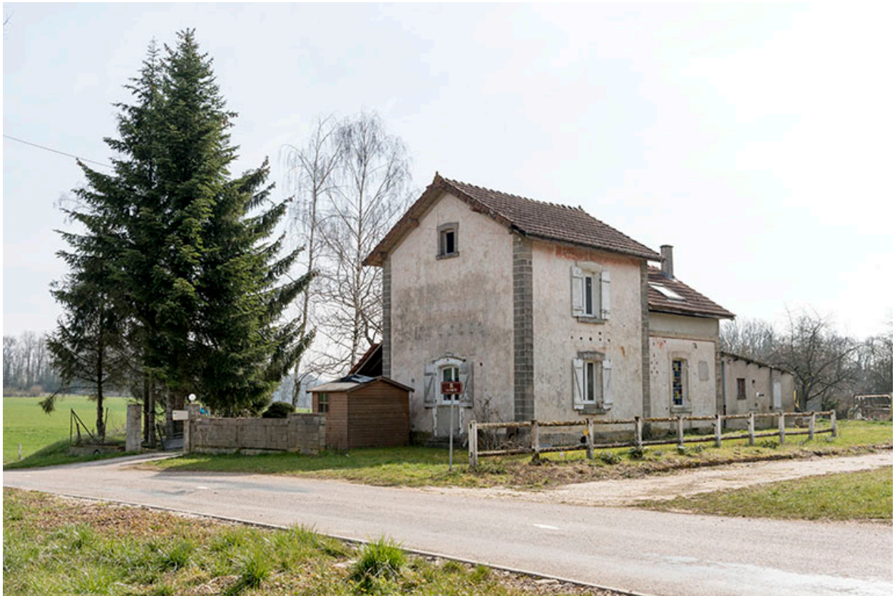
Maison garde-barrière entre Aisey et Bétaucourt.
