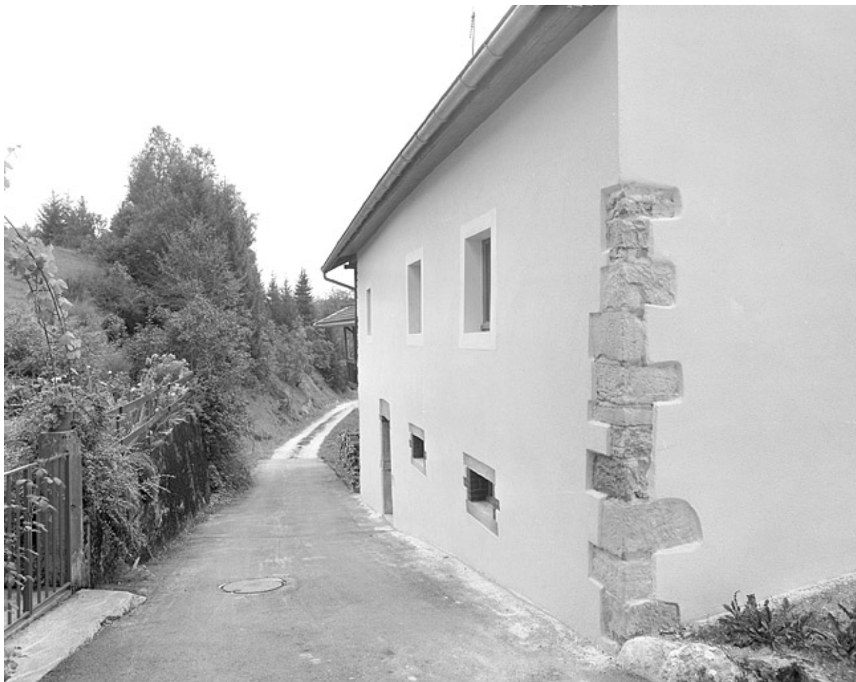
Façade postérieure de la ferme, ancienne étable.
