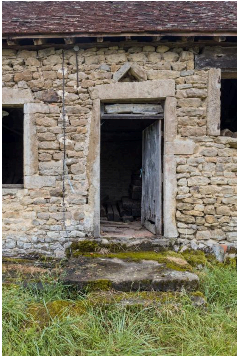
Détail de la dépendance secondaire : porte d'entrée du fournil
